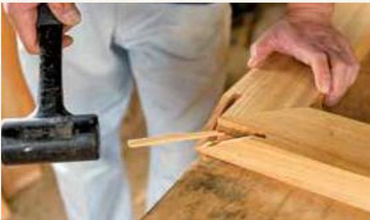
組立時に、「鯨栓」と呼ばれる木片を打ち込むことで、二つの部材がしっかりとつながり、木材の伸縮にも対応できます。
